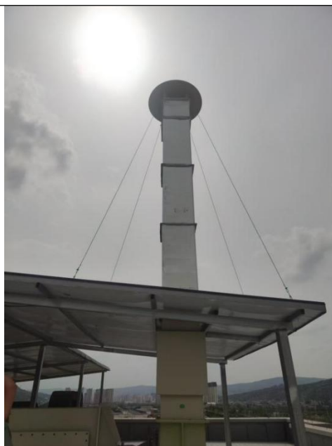
实验废气排气筒
