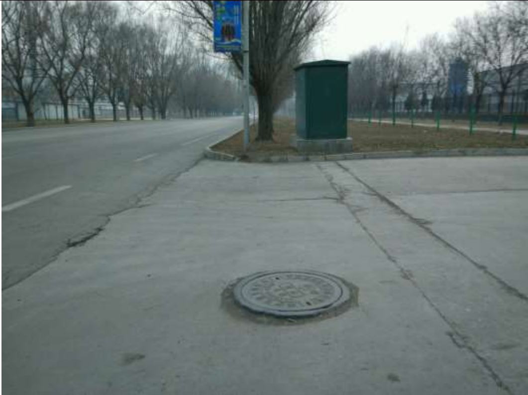
路面恢复（南北路污水管道）
