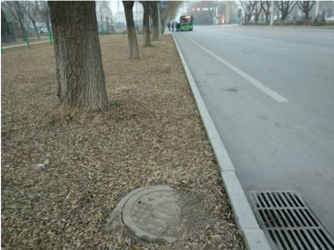
路面恢复（南北路污水管道）
