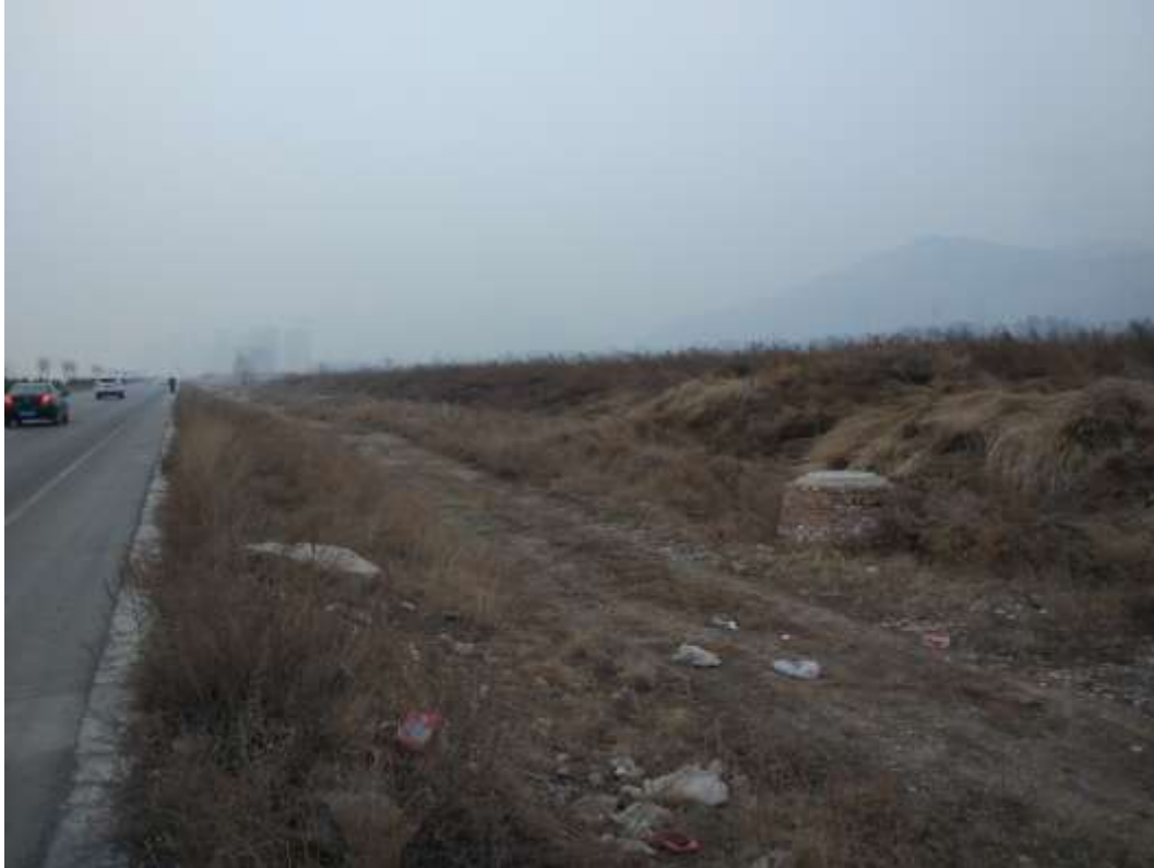
泾河北路段污水管网
