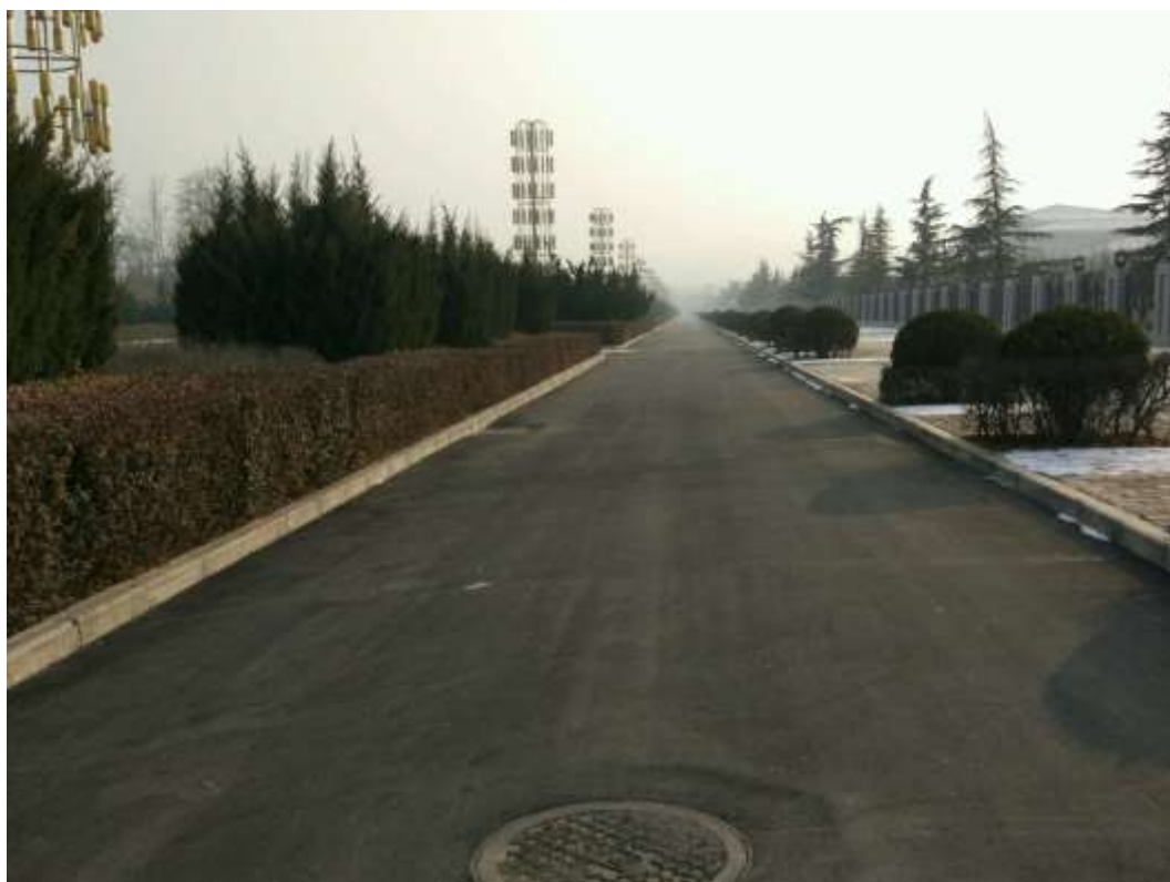
路面恢复（养子寨水源地管道）
